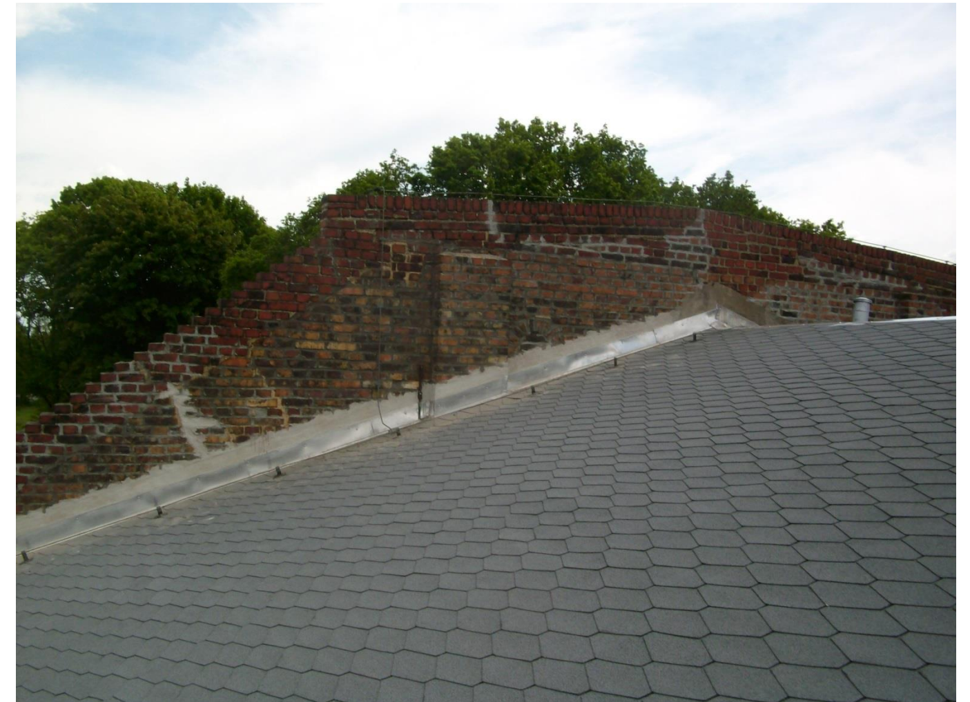
Ein kleines Stück der Dachfläche, die 2019 neu gedeckt wurde.
