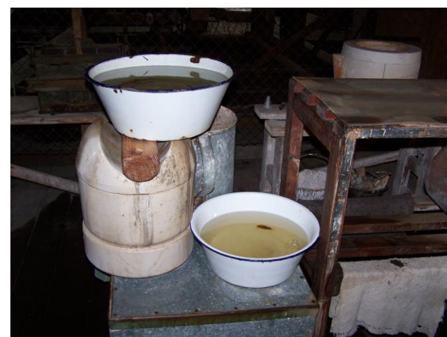
Nach jedem Regenguss standen Pfützen auf den Fußböden und die Auffangbehälter waren voll.
