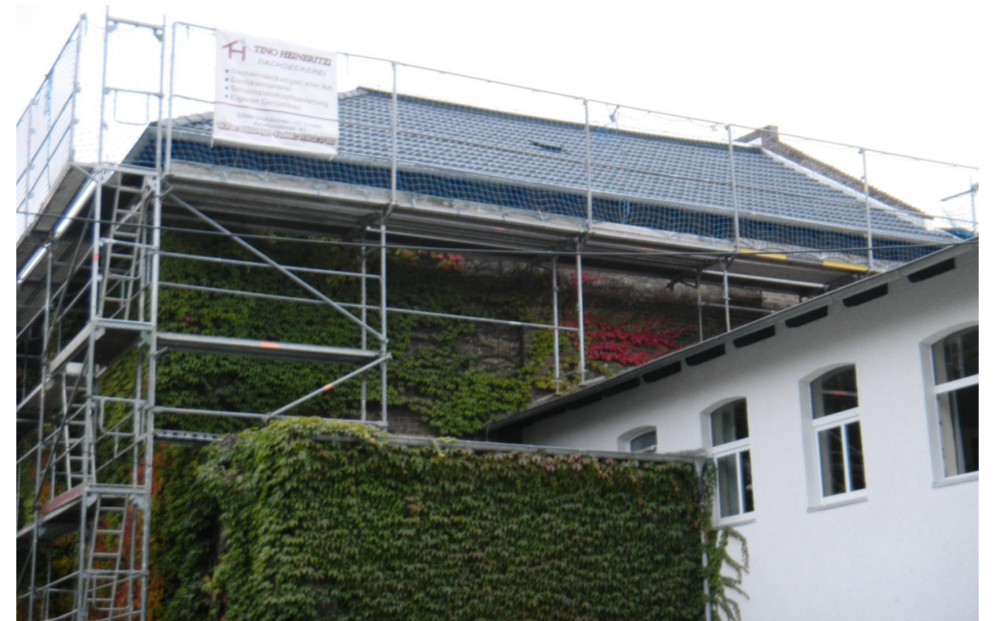
Im Herbst 2016 wurde das Prüffelddach neu gedeckt.
